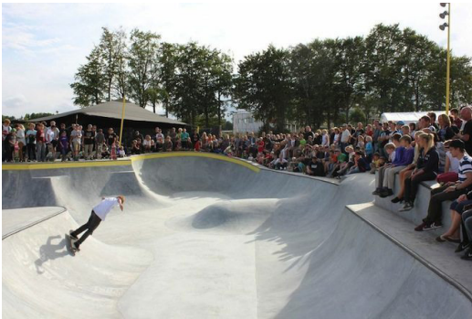
Bild 4. (MySkateSpots, u.å.) Rabalderparken i Köpenhamn är en skatepark som vid stora skyfall kan hålla vatten som en förvaringsbassäng. (Köpenhamn kommun, u.å.)
